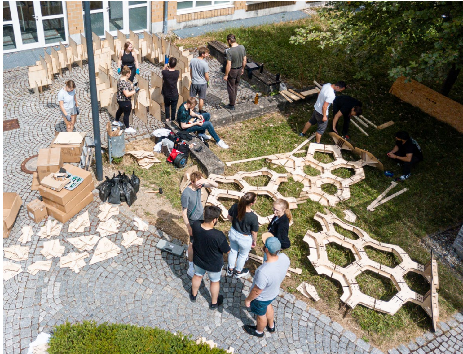
Errichtung der Auflagersegmente
